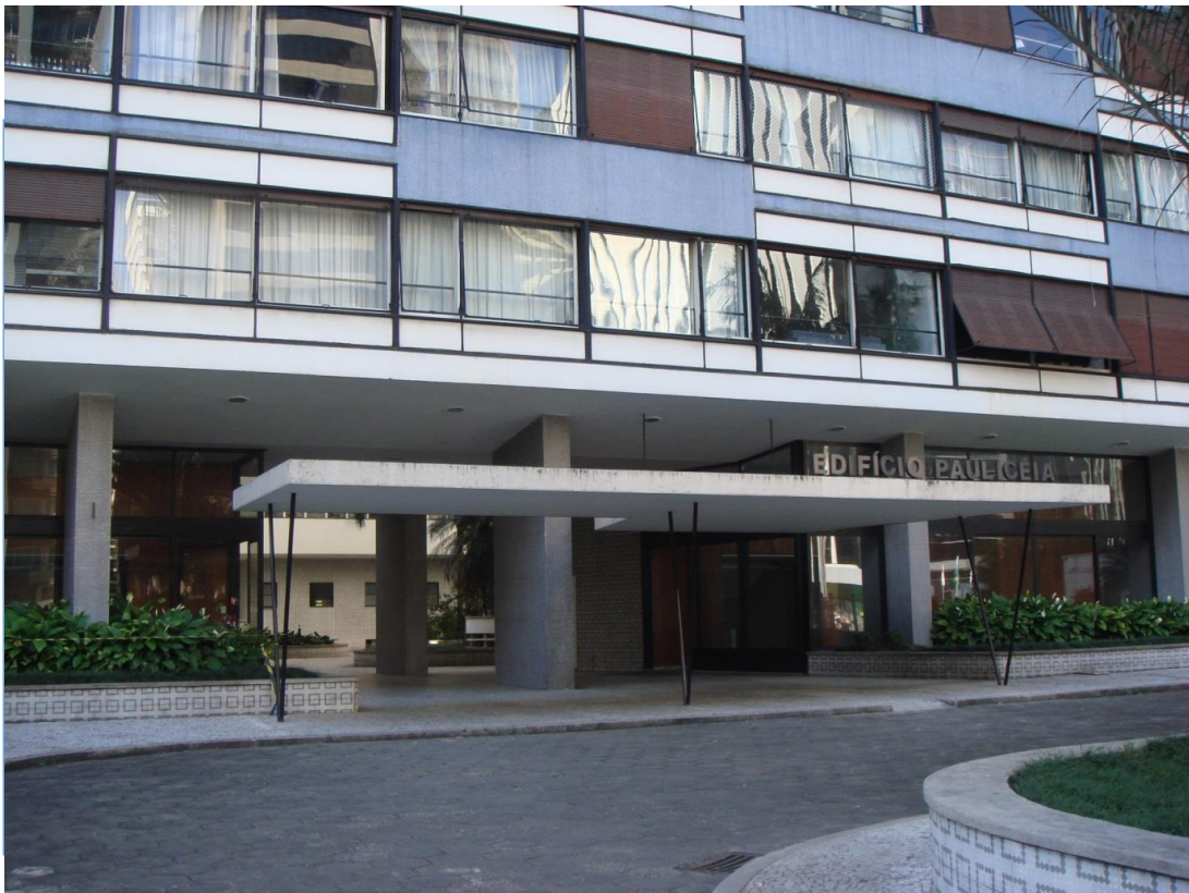
Figure 2. Edifício Paulicéia (arquitetos Jacques Pilon e Giancarlo Gasperini, 1958). Fonte: KURIMOTO, 07 jul. 2017.
